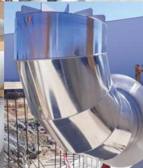
Výroba probíhá ve většině případů z přístřihu, které jsou dodávány v přesně stanovených rozměrech dle požadované dimenze trub.
